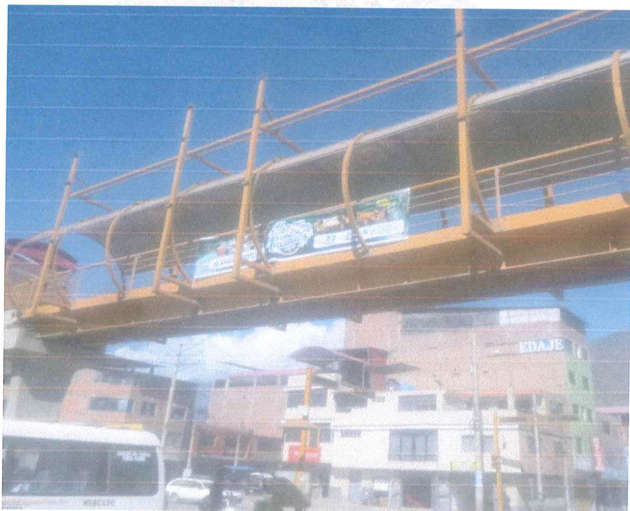
Colocación de pasacalle en la Av. Carretera Central, a la altura del paradero 15.
